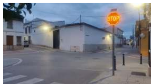
SEÑALIZACIONES LUMINOSAS EN STOP Y CALZADAS
