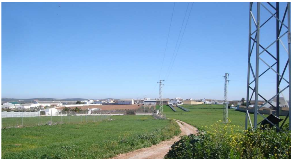
Red de alta tensión en las cercanías del núcleo urbano de El Rubio.
